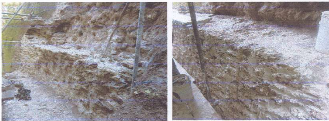
Foto No.9 y 10 Proceso y final de la restauración del segundo cuerpo muro, fachada oeste, Templo V.
