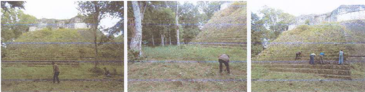
Foto No. 19, 20 y 21, Mostrando el chapeo en plaza, escalinata central de edificio 3D-43.
