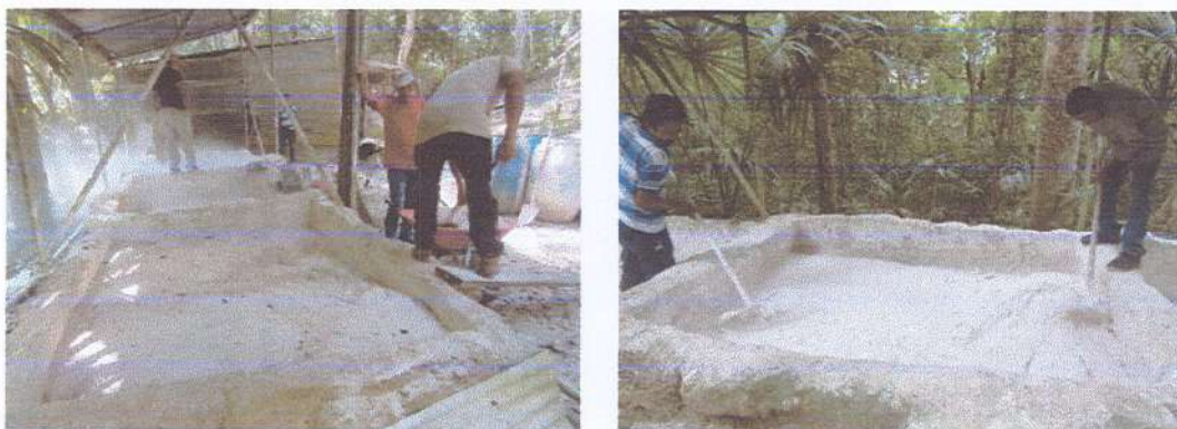
Foto No. 6 y 7, proceso en la elaboración de mezcla
