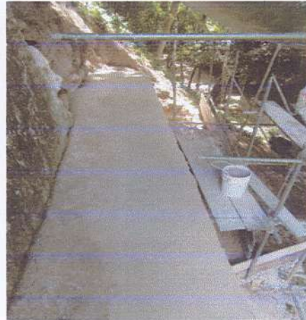
Foto No 13 y 14, Proceso y final de fundición de piso en descanso de segundo basamento, fachada oeste, templo V.
