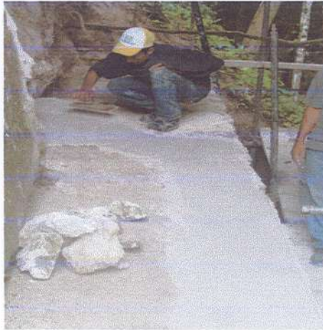
Foto No 13 y 14, Proceso y final de fundición de piso en descanso de segundo basamento, fachada oeste, templo V.
